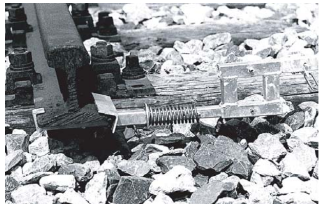
Beugelafstanden op 2,50 m - 2,70 m (4 bielzen tussen de beugels)
